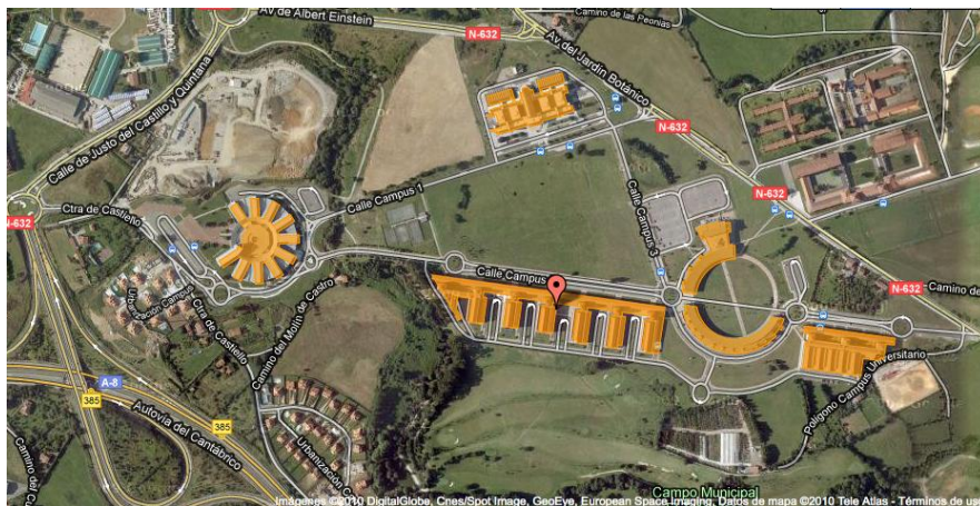
Figura 1.3 Vista aérea del Campus Universitario de Gijón
